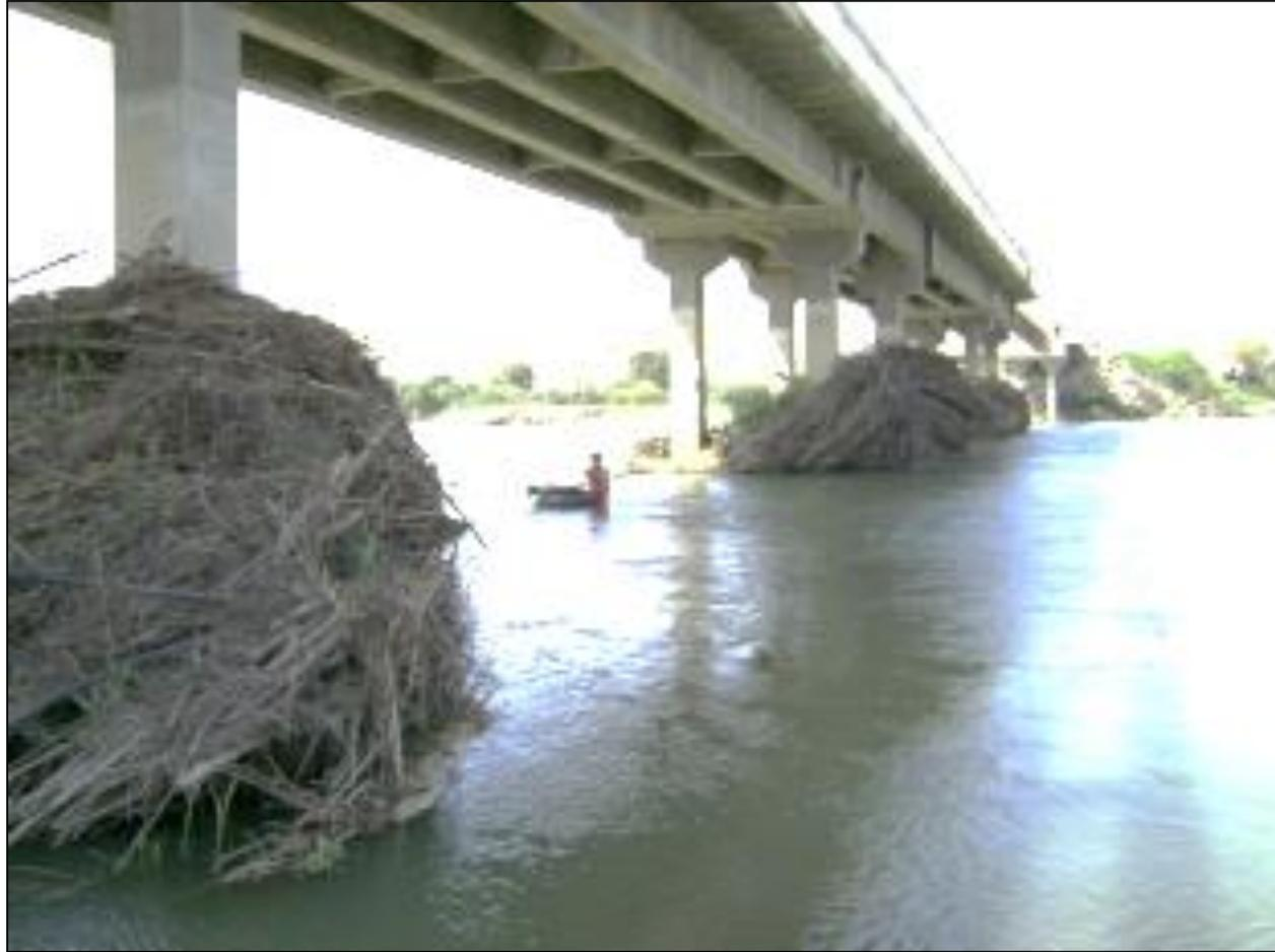
Se debe limpiar el cauce del río, aguas arriba del puente, retirando todo tipo de material potencialmente peligroso, especialmente en tiempo de máximas avenidas, que pueden golpear los pilares del puente, y ayudar a represar el cauce del río junto con la gran cantidad de maleza que arrastra el río.
