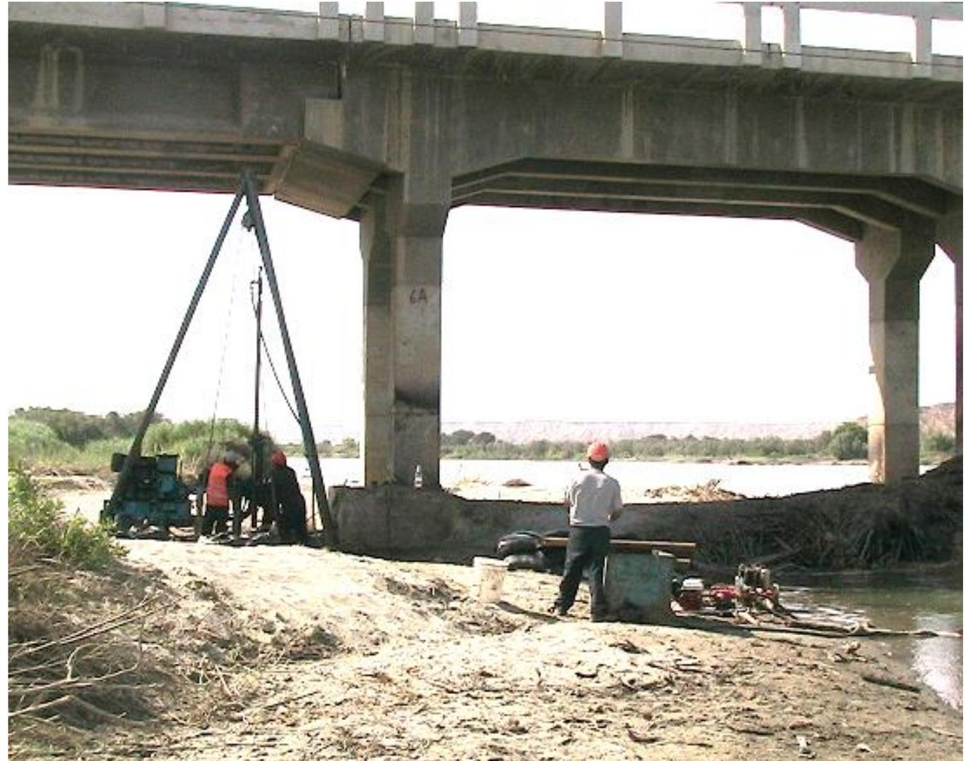
El programa estableció 288.00 m de perforación, según la ubicación de pozos, distribuidos en 09 perforaciones. La línea de perforación utilizada fue HQ y NQ y como revestimiento HW. Como se observa en el siguiente cuadro:
