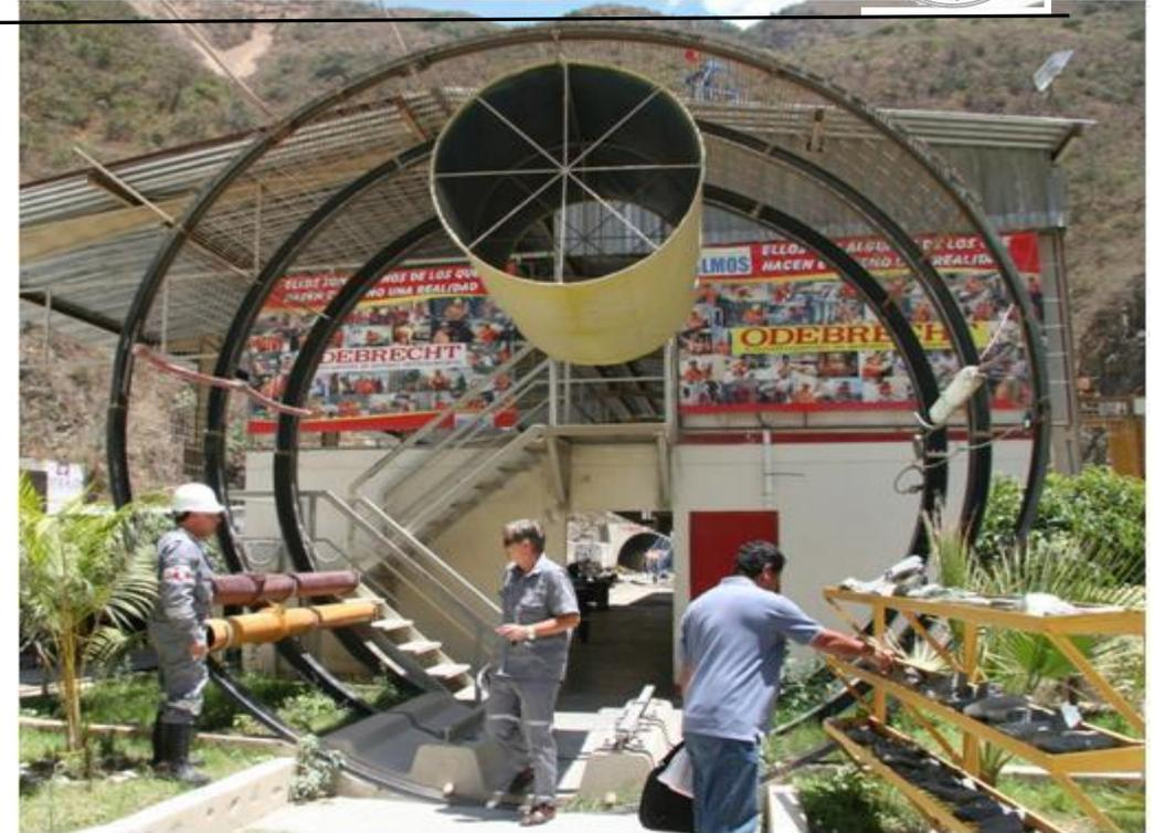
Detalle de los segmentos invertidos de hormigón pre-fabricado que incluyen un canal de drenaje central y abrazaderas de carril preestablecidas.
