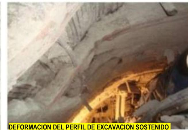
DEFORMACION DEL PERFIL DE EXCAVACION SOSTENIDO
